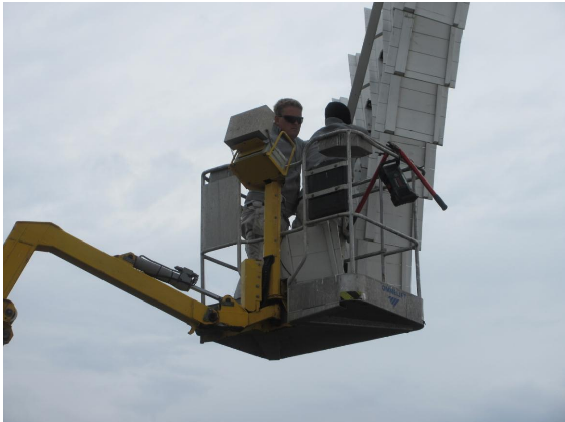
Vingerne står blot i frige gear ( Persen = Bremsen er løftet op på krogen) Liften bruges til at hente den næste vinge og dreje den ned i lodret
