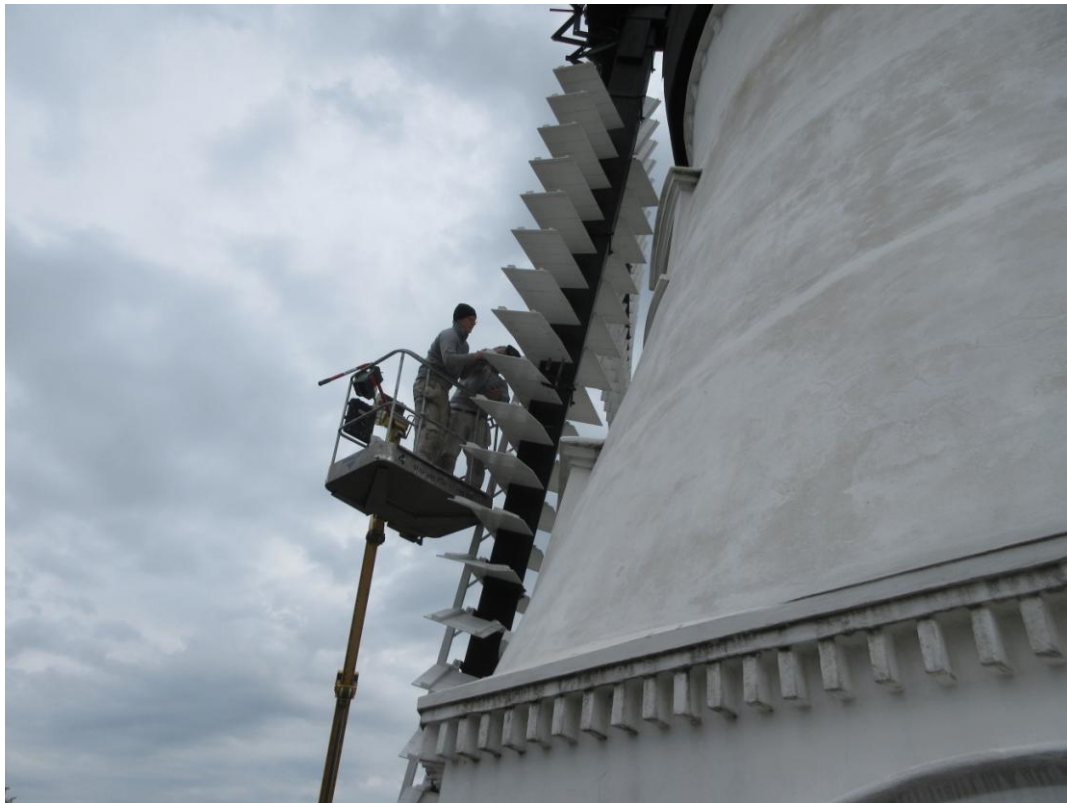
2 mand i liften. Der bukkes to stk stål med 4 forborede huller. Der sættes skruevinger på.
